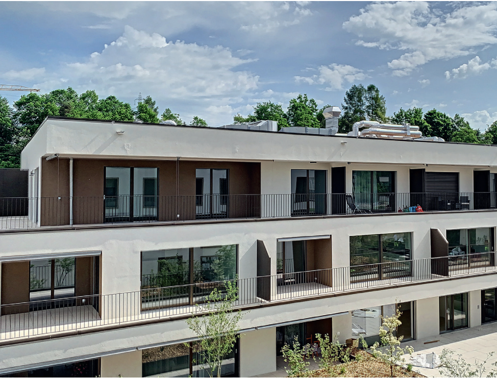
Route Ancienne Papeterie 2-4, Marly
