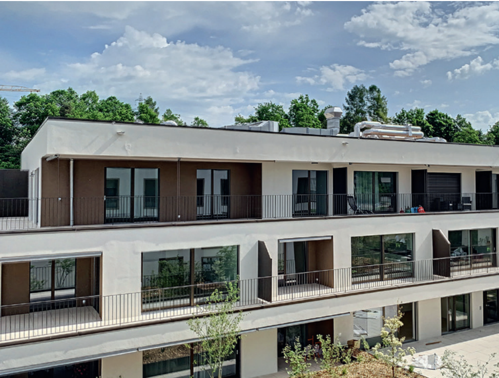
Route Ancienne Papeterie 2-4, Marly
