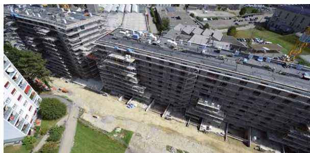
Fribourg, rte de la Glâne 15-17, évolution du chantier 2017-2018
